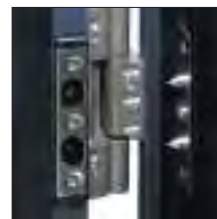
Doigt anti-soulèvement côté paumelles
