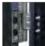
Doigt anti-soulèvement côté paumelles
